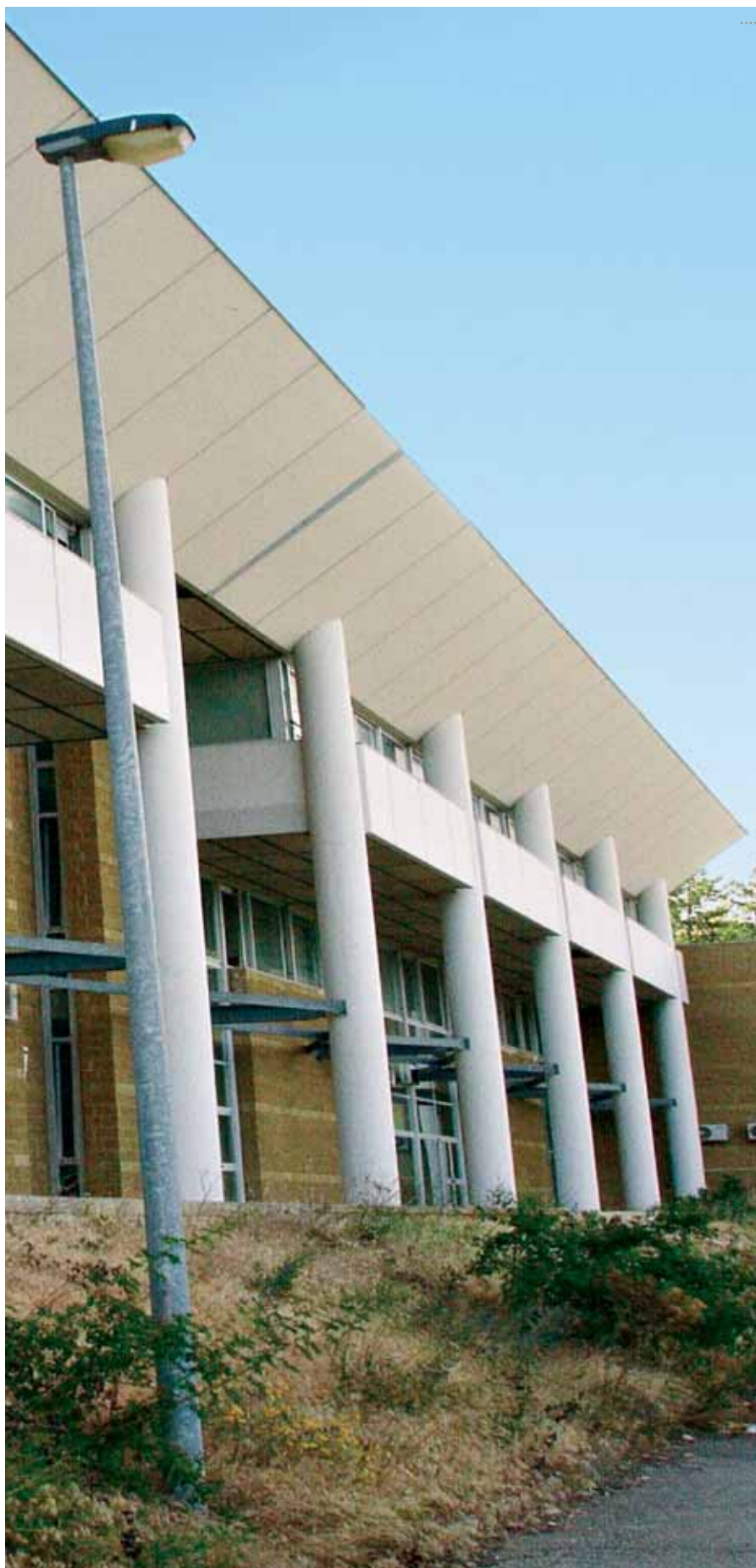
Il padiglione dell'Università in fase avanzata di ricostruzione
